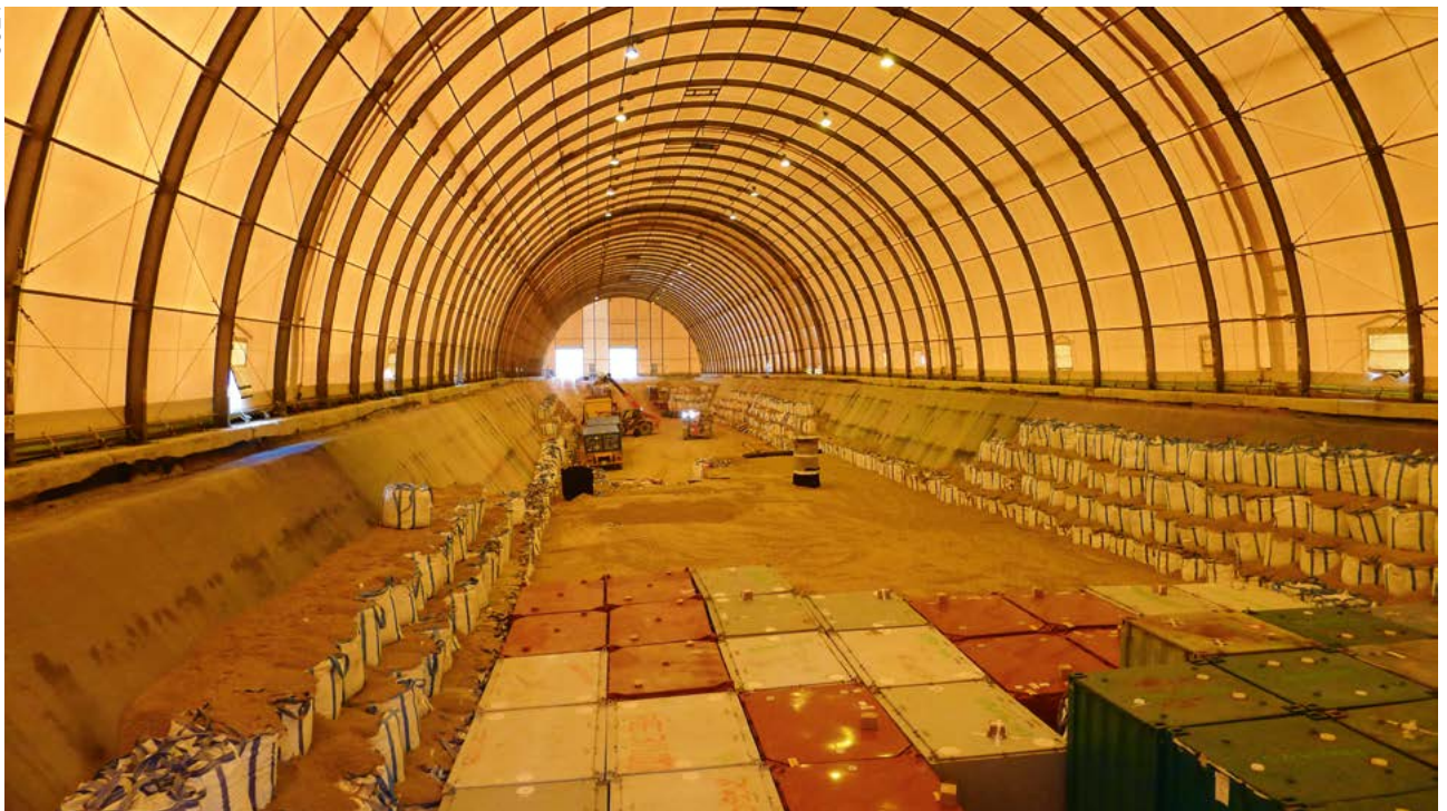
Exploitation par l'Andra d'une alvéole contenant des déchets TFA © Andra.
