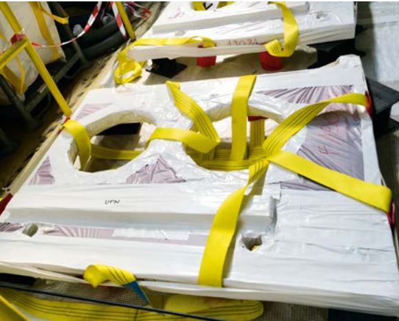
Bâtiment 18, protections biologiques de l'enceinte Carmen conditionnées pour leur évacuation.
