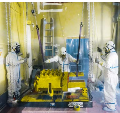
Bâtiment 10, démontage d'un palan.
