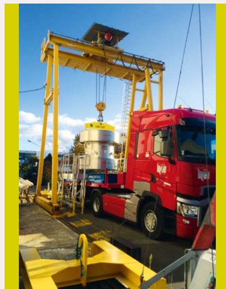
Photos de couverture : Chargement de l'emballage Tirade destiné au transport de colis radioactifs. © M-P Brémond CEA
