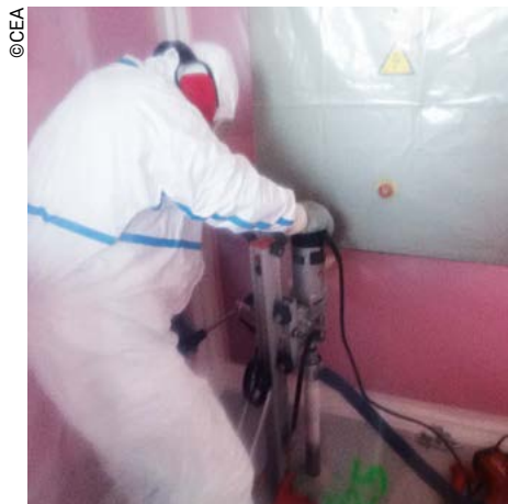
Bâtiment 53, opérateur procédant à l'assainissement du sol.
