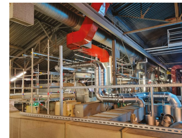
Montage de la nouvelle ventilation de Petrus. ©CEA - UADF
