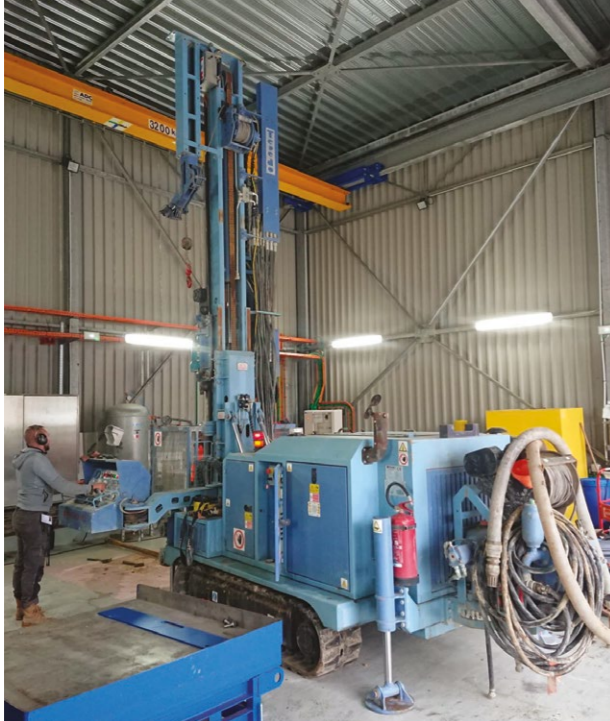
Poursuite des études géotechniques, carottage du sol bâtiment 108 de l'INB 166 ©CEA UADF
